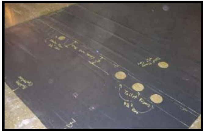
Figure 39: MEP Hole Template (Mensch)
