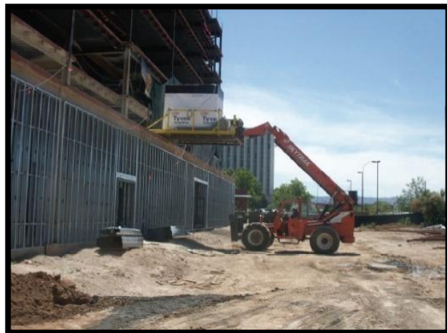
Figure 35: Placement with Lull (Mensch)
